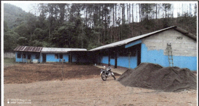
Foto 8: Trabajos de sustitución de torta de concreto en corredor.
