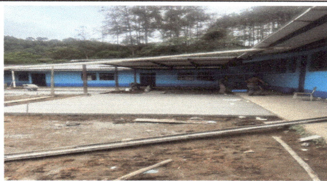
Foto 9: Trabajos de sustitución de torta de concreto en corredor.
