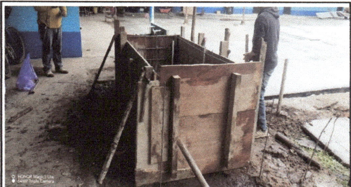
Foto 10: Vista de Pila de cemento en porceso de renovación.
