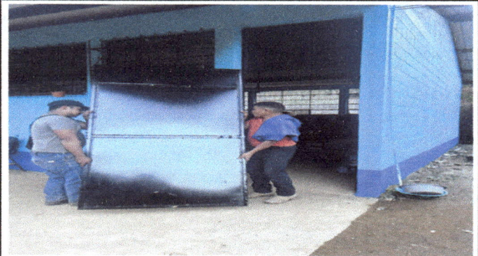
Foto 2: Puertas pintadas siendo instaladas nuevamente y pintura nueva aplicada .
