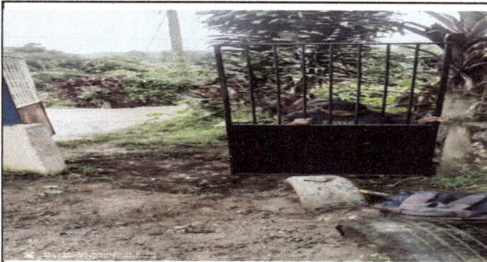
Foto 3: Portón de la entrada principal del centro educativo siendo sustituido.
