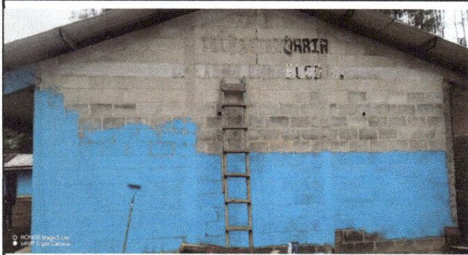
Foto 7: Paredes exteriores que están siendo pintadas.
