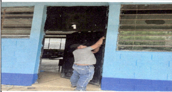
Foto1: Puertas en proceso de mantenimiento del módulo 1.
